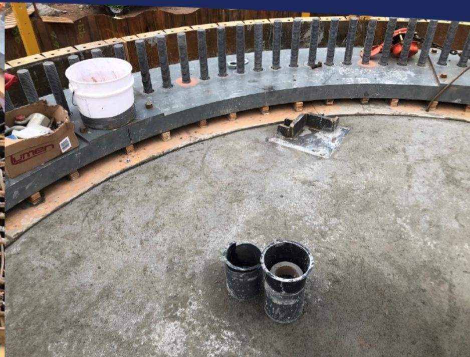
*Du béton est coulé en continu dans la partie supérieure de la fondation (le fût) jusqu'à remplir complètement le coffrage.*
