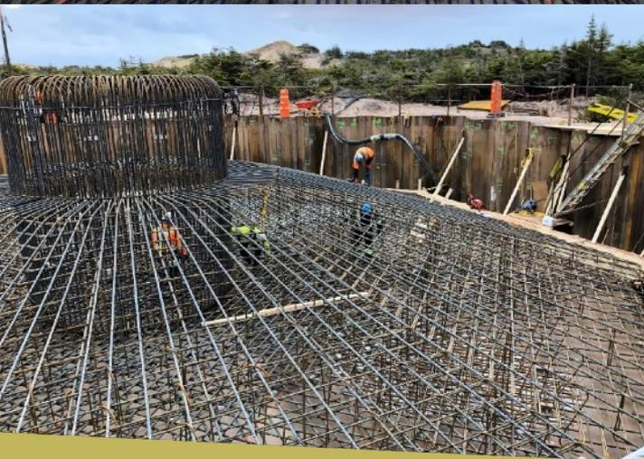
*Ces structures servent à transmettre l'effort de l'éolienne à la base de béton qui sera coulée par la suite et qui recouvrira les barres d'acier.*
