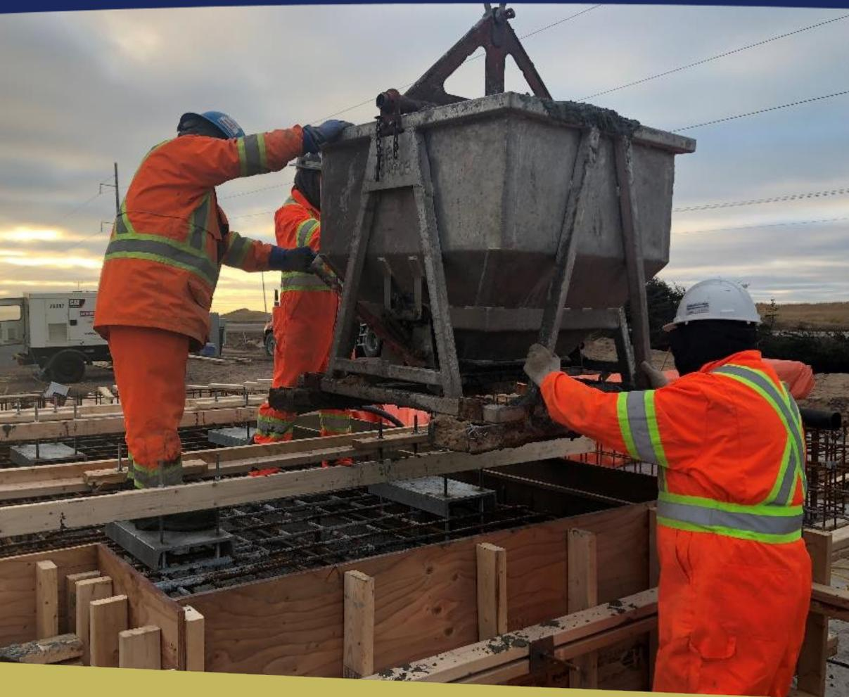
Le béton est coulé à l'intérieur du coffrage de la base et recouvre l'armature métallique.
