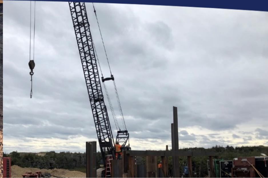
*Les palplanches servent à éviter l'éboulement du sable durant la construction des fondations.*
