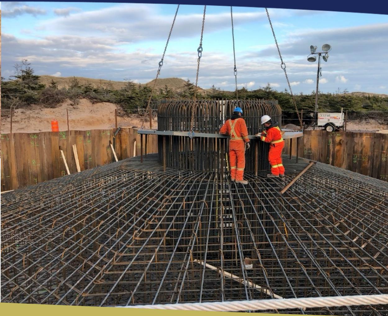
*Le cercle de boulonnage servira à accueillir les boulons d'ancrage de la tour de l'éolienne*
