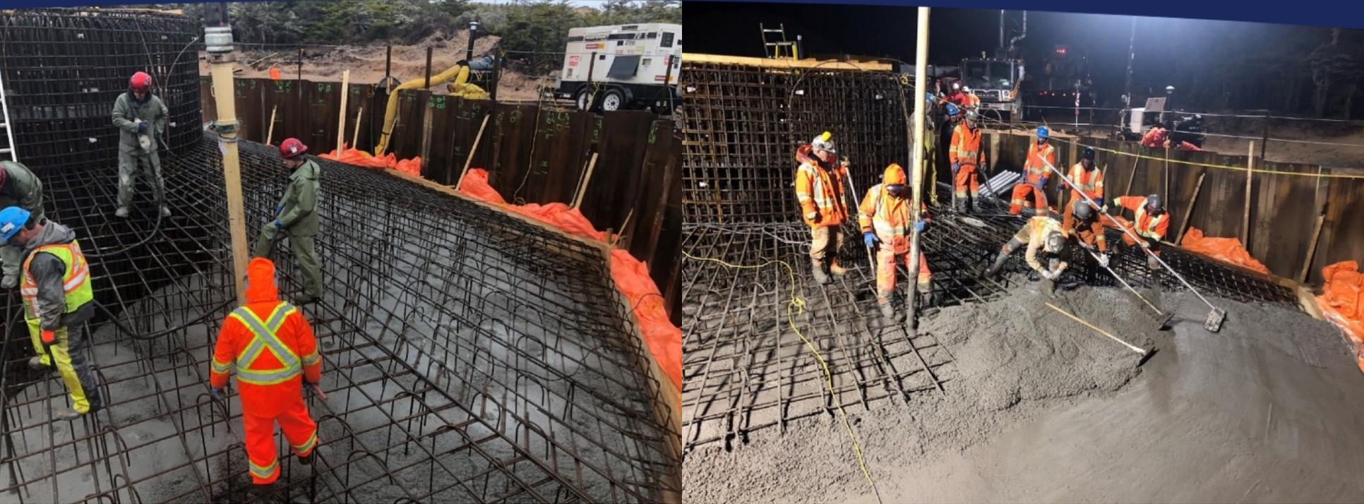
*Le béton est coulé en une seule fois à l'intérieur du coffrage et il est mis en forme de manière à recouvrir l'armature métallique de la partie inférieure de la fondation.*
