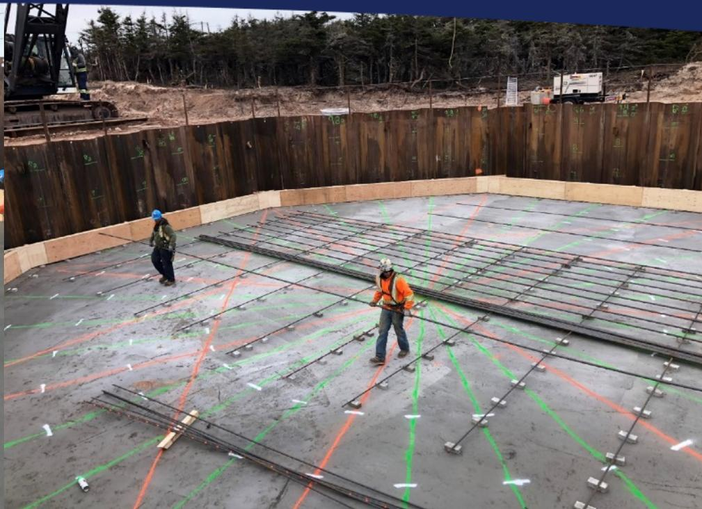
*Le coffrage permet de confiner le béton liquide et ainsi délimité la base des fondations.*
