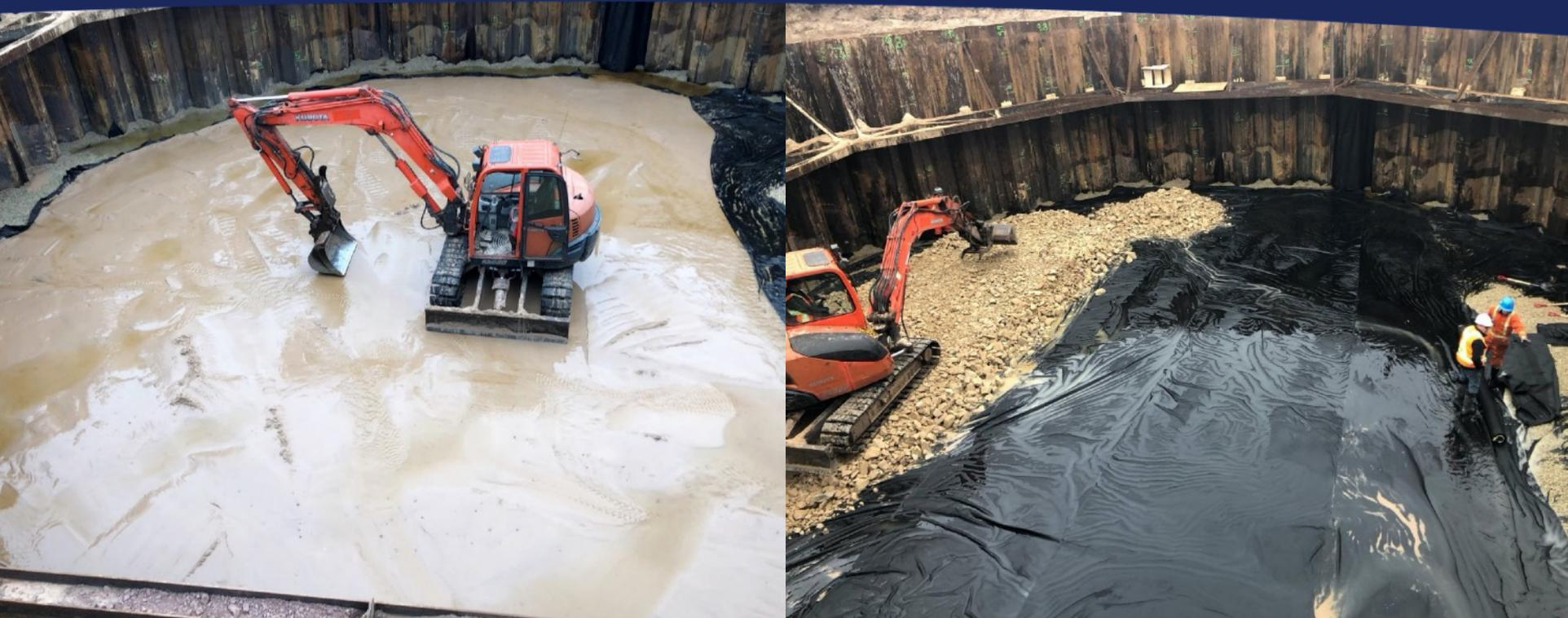
*La membrane géotextile sert à séparer le sol naturel et le matériel de remblai et à éviter qu'ils ne se mélangent.*
