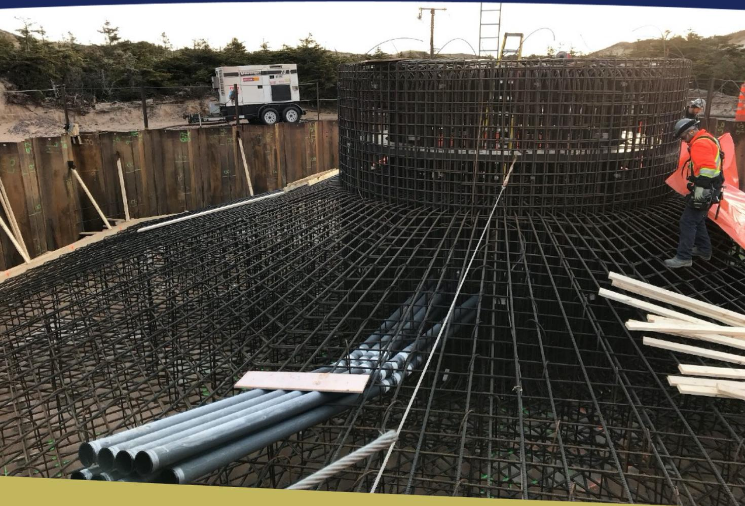
*La cage du fût est installée sur le cercle de boulonnage.*
