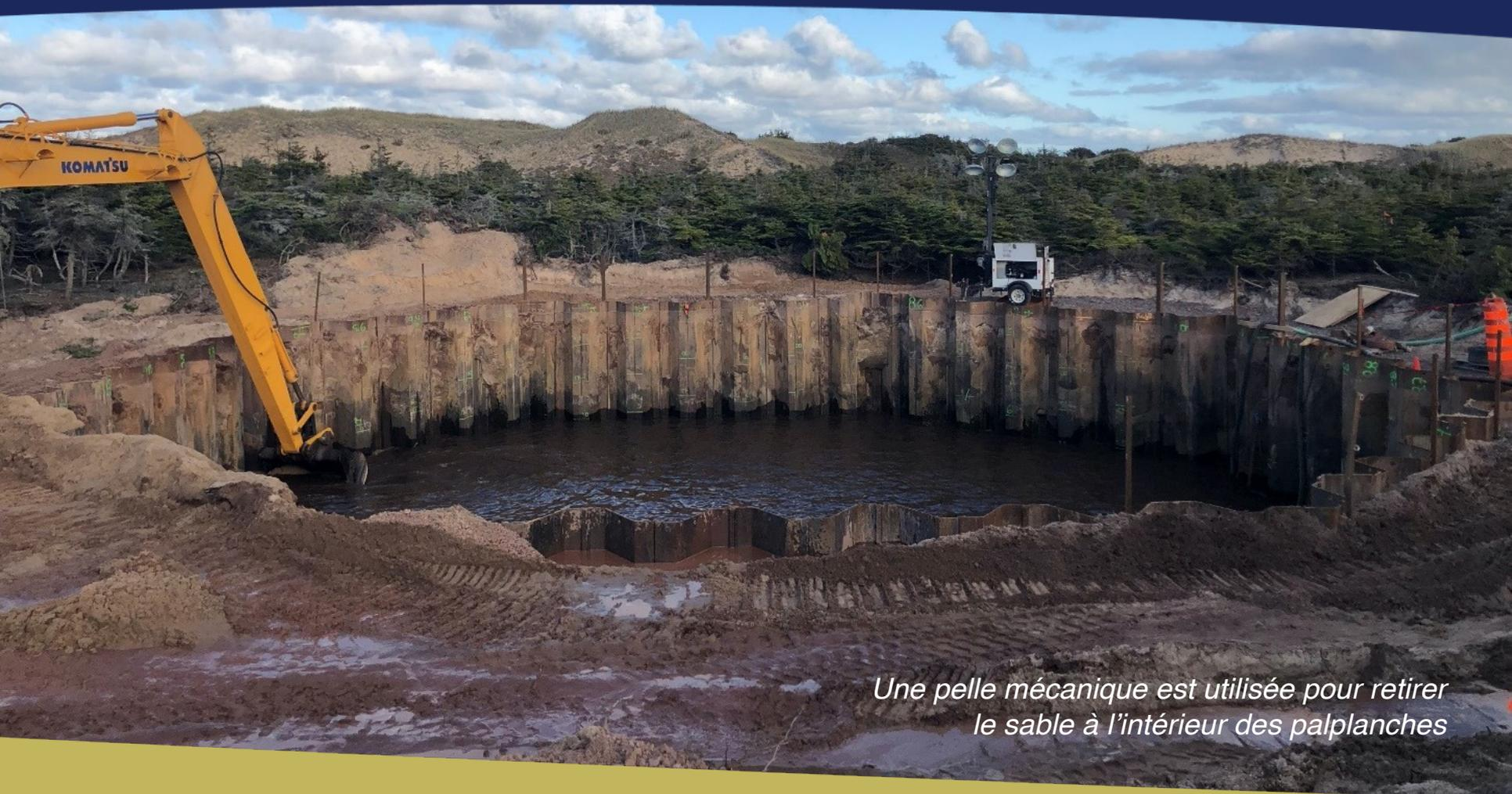
*Une pelle mécanique est utilisée pour retirer le sable à l'intérieur des palplanches*
