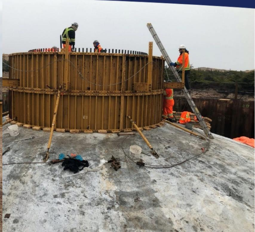
*Le coffrage de la partie supérieure est installé à l'aide d'une grue*
