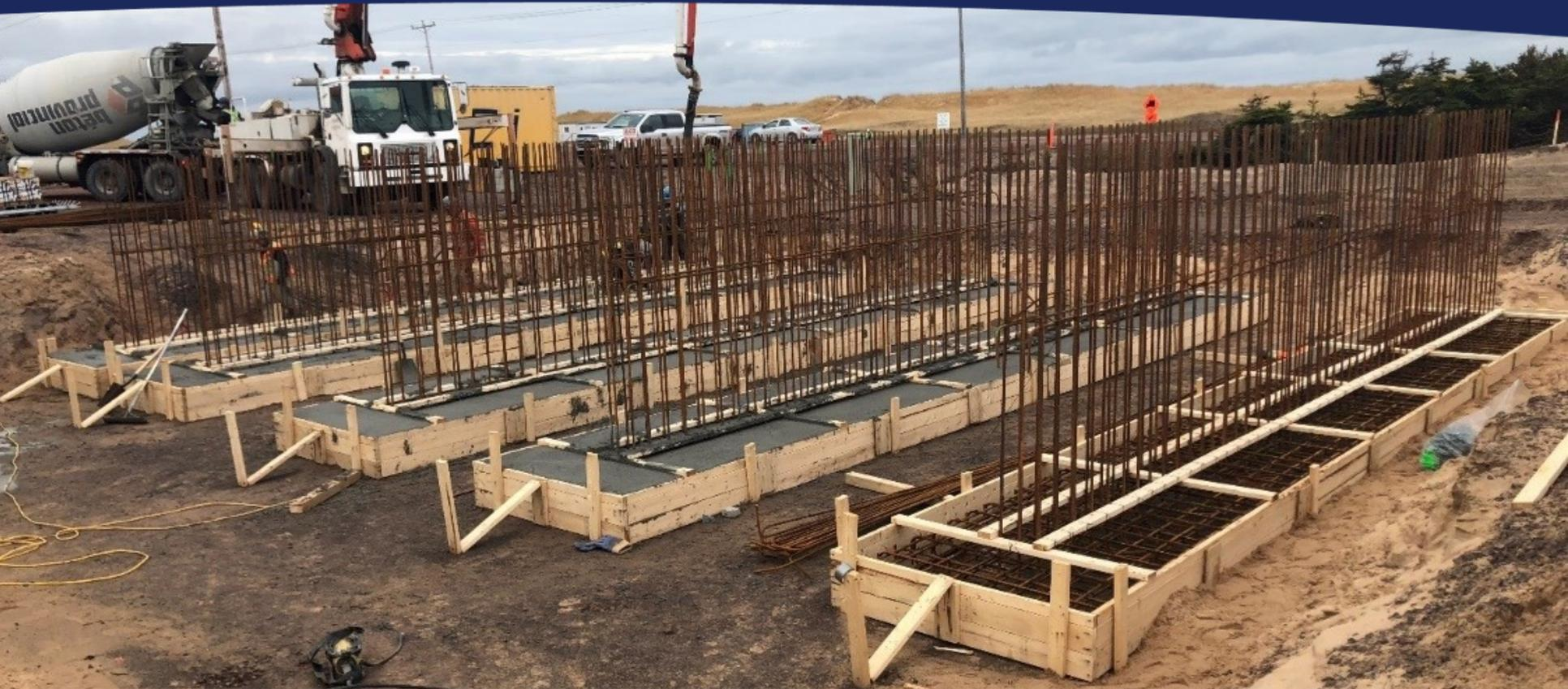
Installation du coffrage, mise en place de l'armature de la fondation du bâtiment de service et début de la coulée de la fondation.
