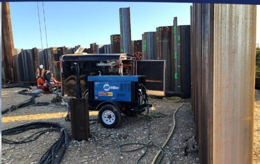
*Les palplanches sont enfoncées dans le sable afin de former un mur de soutènement en forme d'octogone autour de l'emplacement où seront construites les fondations*
